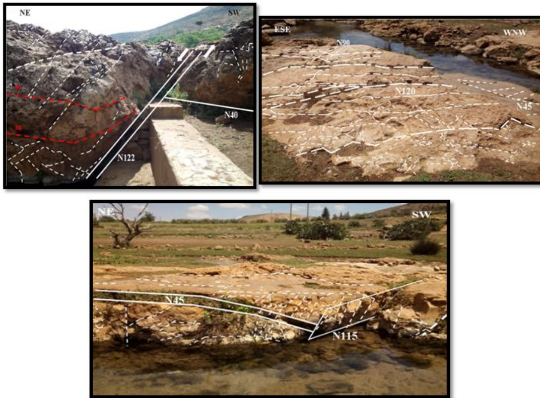
Figure 6 : Photos montrant les fractures au niveau d'Ain Maarouf
